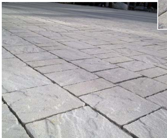
Pavimentazione Magnetti Albedo, SRI ≥ 80.
