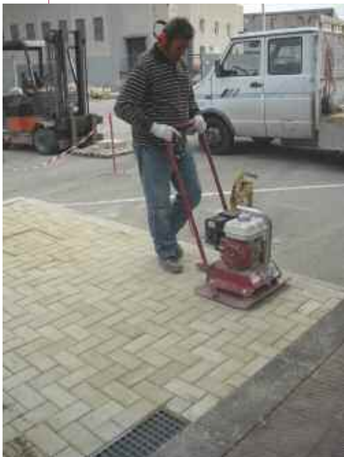
Vibrocompattazione dei masselli dopo l'intasamento dei giunti
