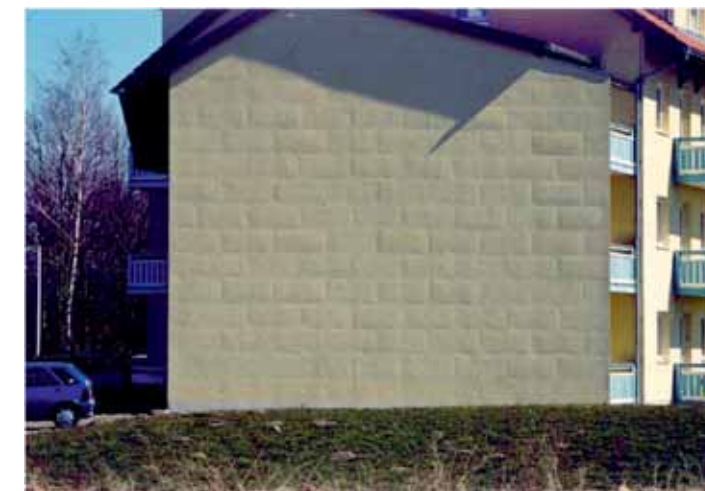
Effetto “materasso” dovuto alla non corretta distribuzione dell'adesivo tra pannello isolante e supporto.
